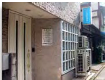
高井戸駅から徒歩近い、住宅街に建っています。
